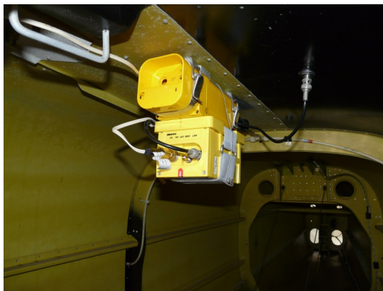
ELT Einbau (Eigenbau)
